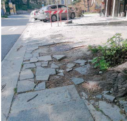
COLLECCHIO I marciapiedi sconnessi in via Galaverna.
